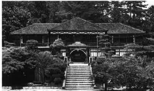
旧吹屋小学校本館 高梁市 明治42年 岡山県指定重要文化財
